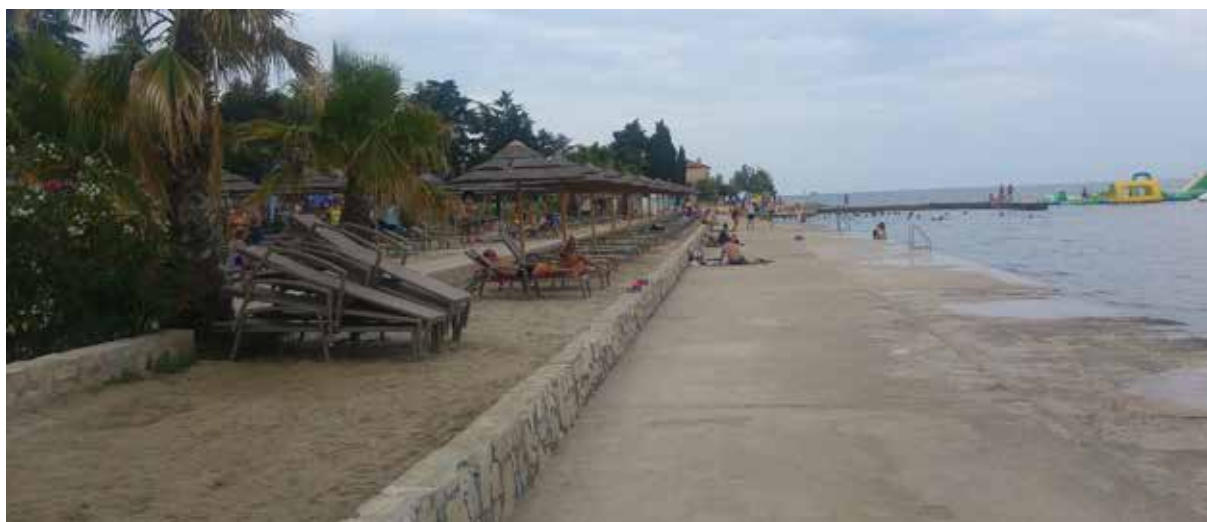
Slika 3: Betonirani dio obale i sunčalište na pješčanoj površini odijeljeno zidom.
